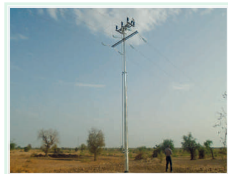
Le projet de Développement du secteur de l'énergie
