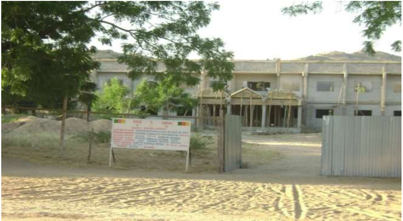
Photo 7 : Hôtel de ville de Mora en construction
