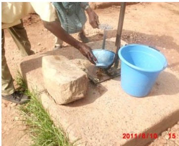
Photo 19 : Processus d'amorçage d'un forage en cours de dégradation à Bindjourni
