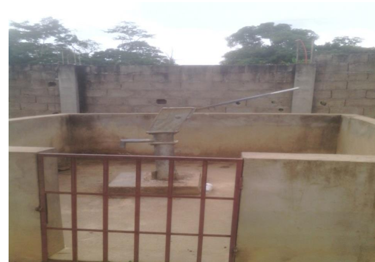
Photo 2 : Forage fonctionnel à la Mairie de Lobo
