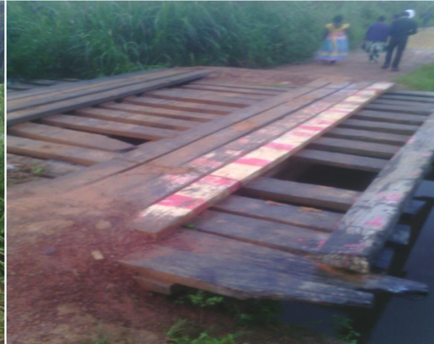
Photo 5: Ponceau en bois sur la rivière Lobo
