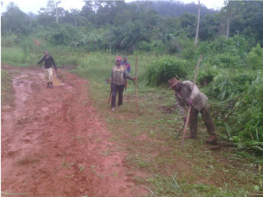
Photo 4: Travaux d'entretien de la route OZOM II-OZOM III
