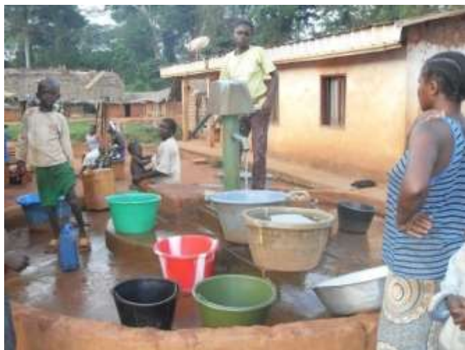
PHOTO 13 : Une vue de l'infrastructure hydraulique de Bitam Yen
