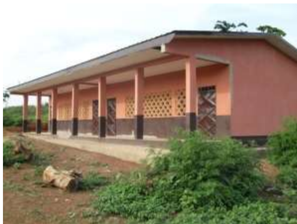
PHOTO 10: Vue du nouveau bâtiment de l'EP de Kamba Miéri
