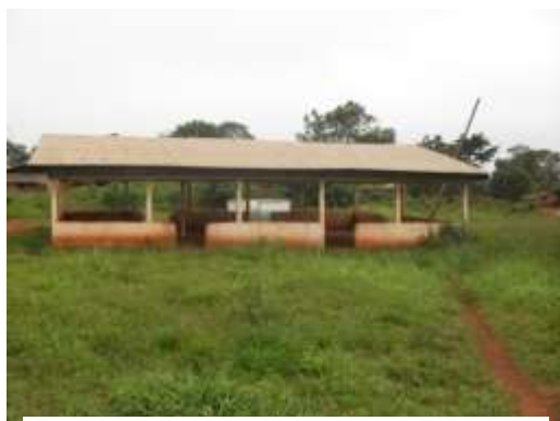
PHOTO 8 : Une vue du hangar du marché abandonné de Nguélébok
