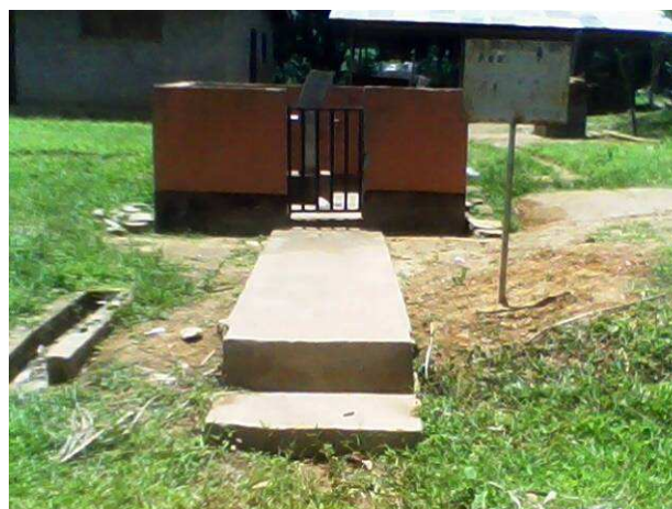
Photo 12: Un point d'eau aménagé dans le village Nkolngui
