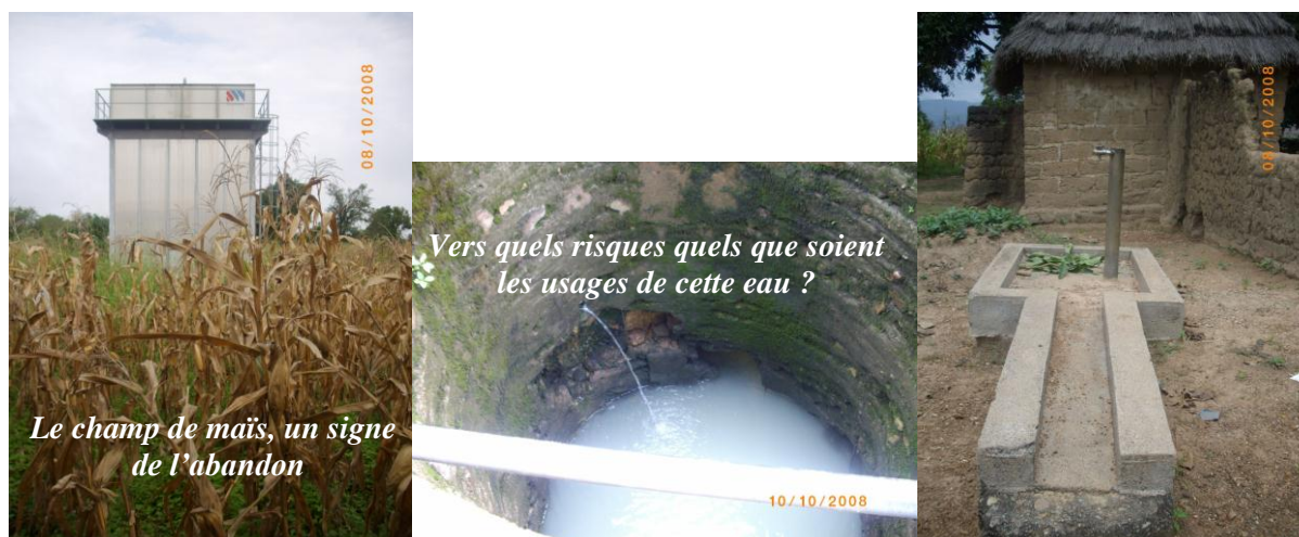
Photo 10 : Etat des infrastructures hydrauliques dans la ville de Mayo-Baléo
