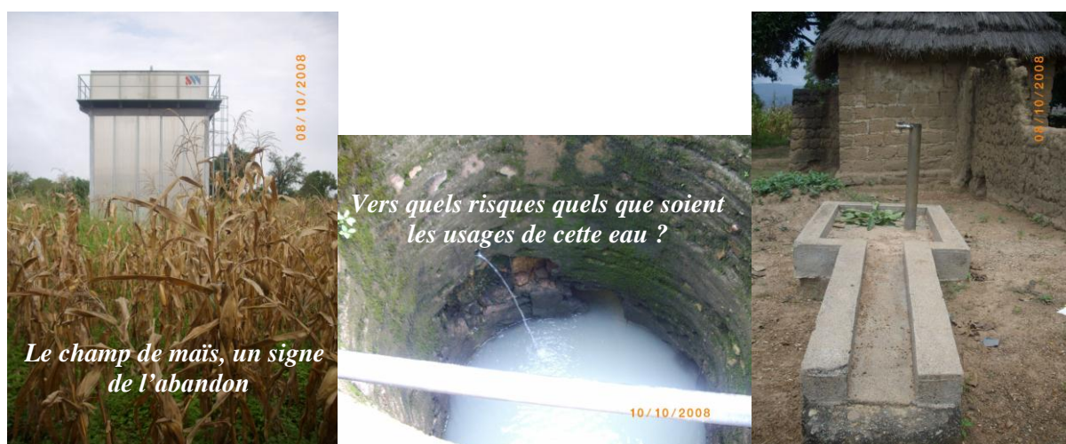
Photo 5 : Etat des infrastructures hydrauliques dans la ville de Mayo-Baléo
