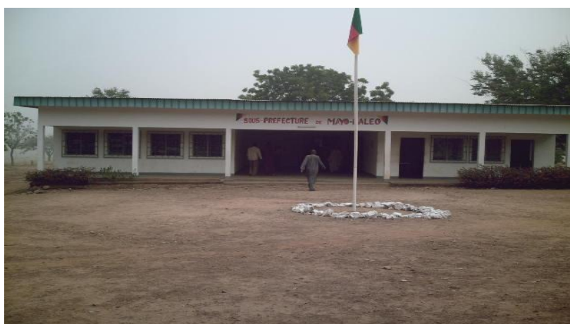
Photo 7 : Bâtiment de la sous-préfecture de l'arrondissement de Mayo-Baléo (Cliché ADDUCOB, Novembre 2008)
