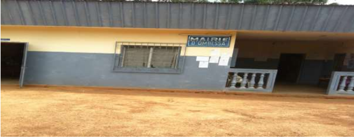
Photo 2 : Batiment hors norme de la Mairie d'Ombessa
