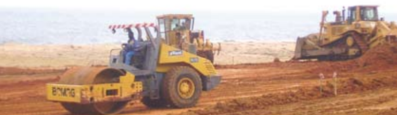
Travaux de terrassement du site
